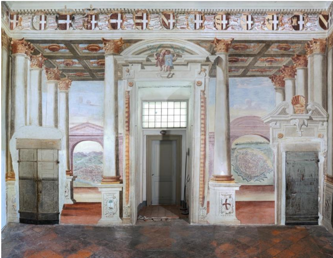
Il salone dei Savoia dopo i lavori di restauro | ph. Morelli Mesturini - FAI
